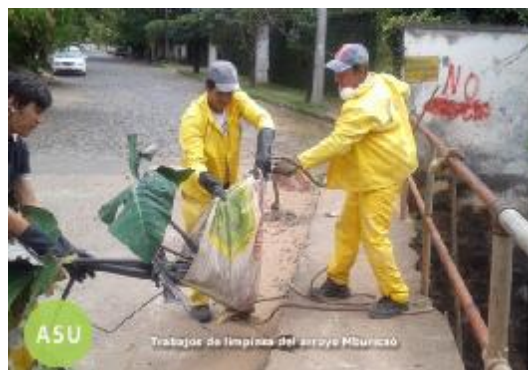
Trabajos de limpieza del arroyo Mburicaó.
