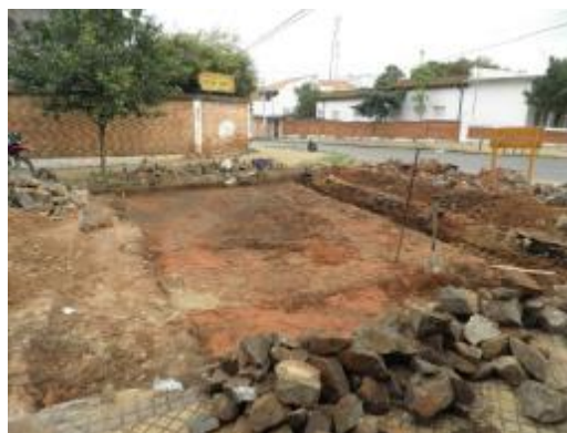
Trabajos de empedrado de calles en Asunción.
