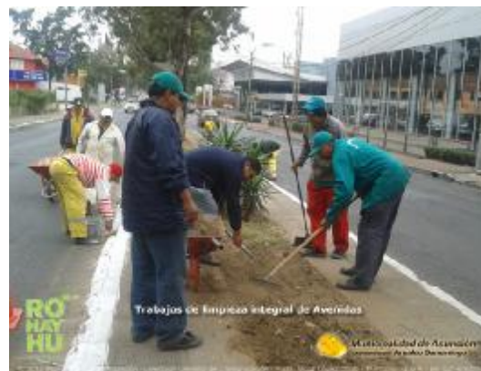
Trabajos de limpieza integral de Avenidas.
