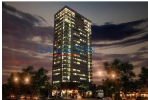
Edificio Miami Tower.
