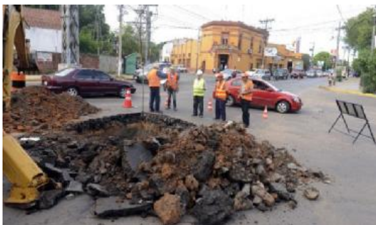
Inicio de la construcción del alcantarillado sanitario en la Av. Artigas.
