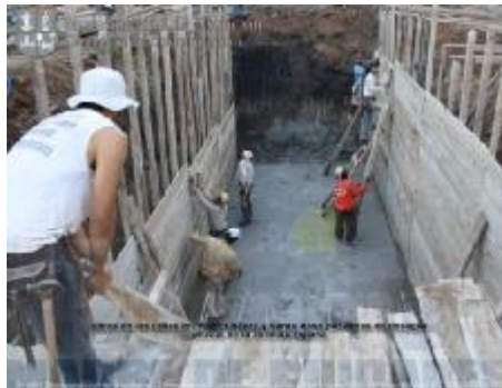
Ejecución del desagüe pluvial en la Av. España.
